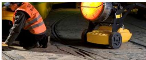
Sovelor FLASH chantier
